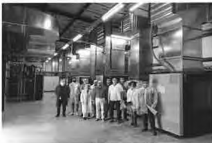
Новата компресорна станция
