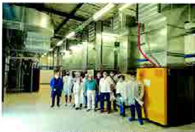
Новата компресорна станция
